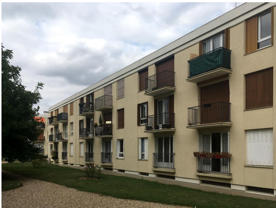
État 2018. Photo Vincent Lesné.
