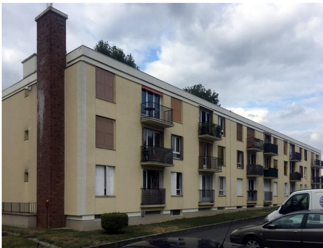
État 2018. Photo Vincent Lesné.
