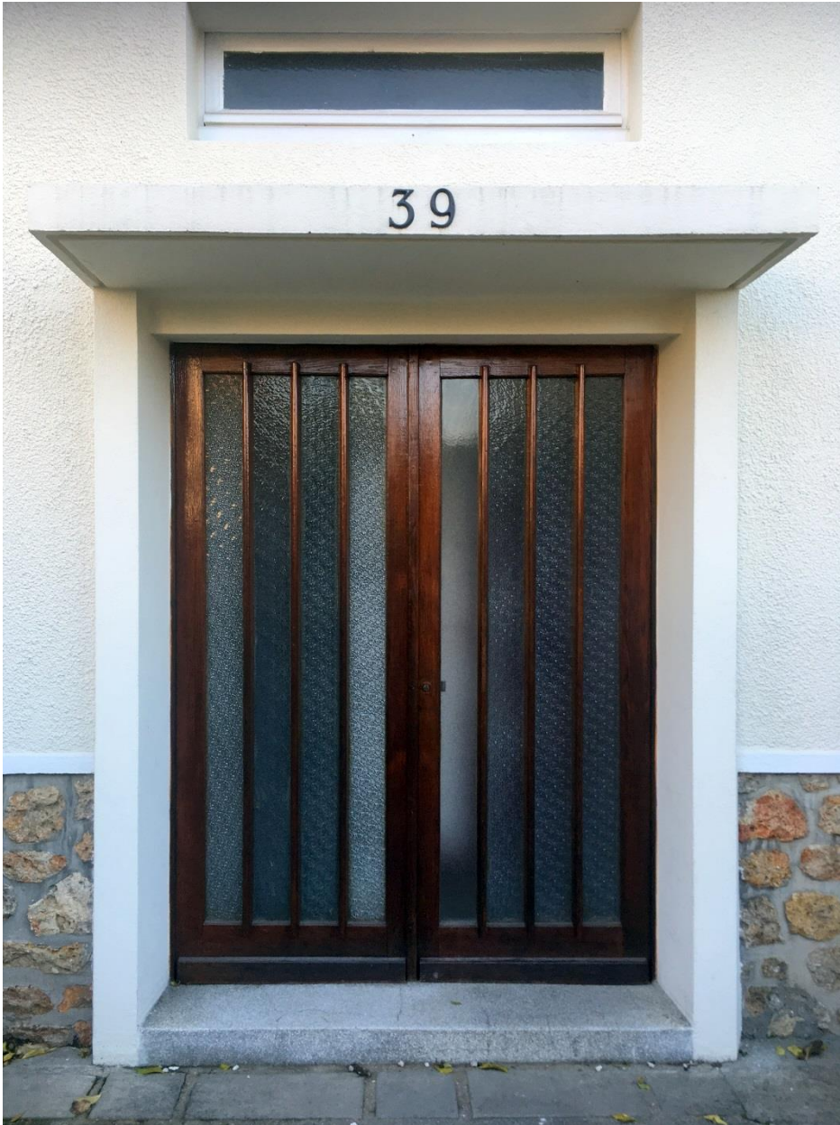
État 2018. Détail de l'entrée. Photo Vincent Lesné.
