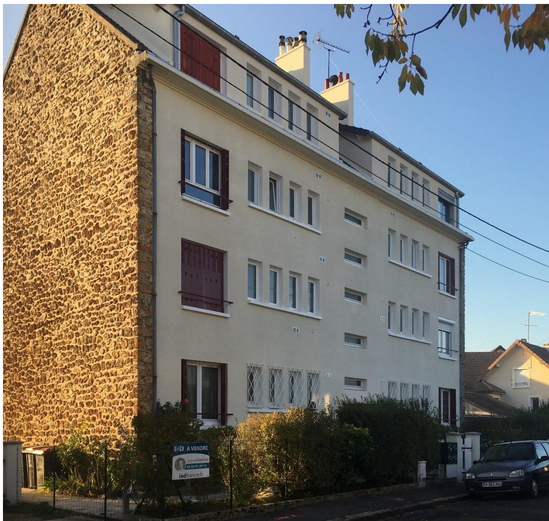
État 2018. Photo Vincent Lesné.
