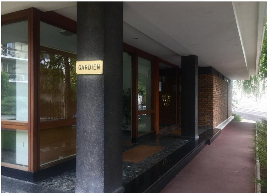
État 2018. Hall d'entrée. Photo Vincent Lesné.
