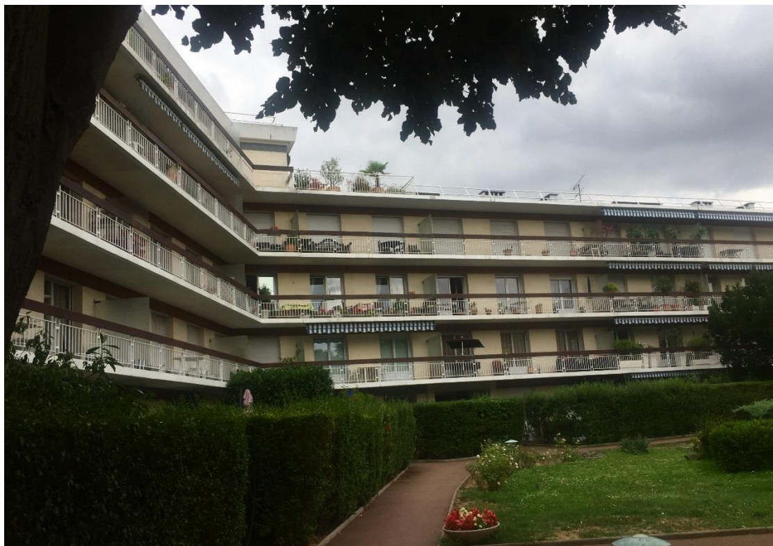
État 2018. Photo Vincent Lesné.
