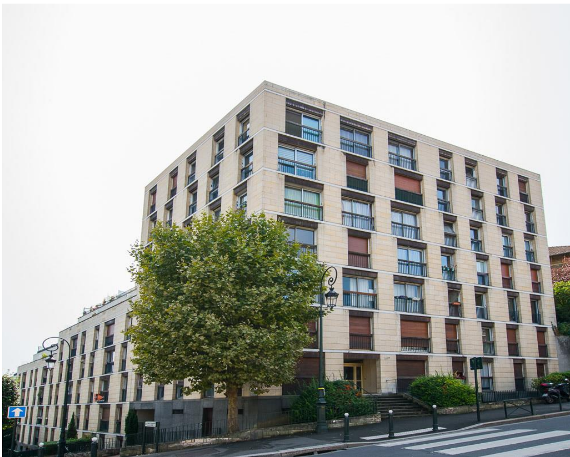
État 2017. Vue d'ensemble. Photo Arnaud Lesné.
