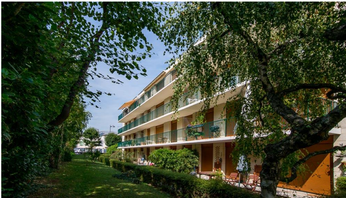
État 2017. Façade sur le jardin. Photos Arnaud Lesné.
