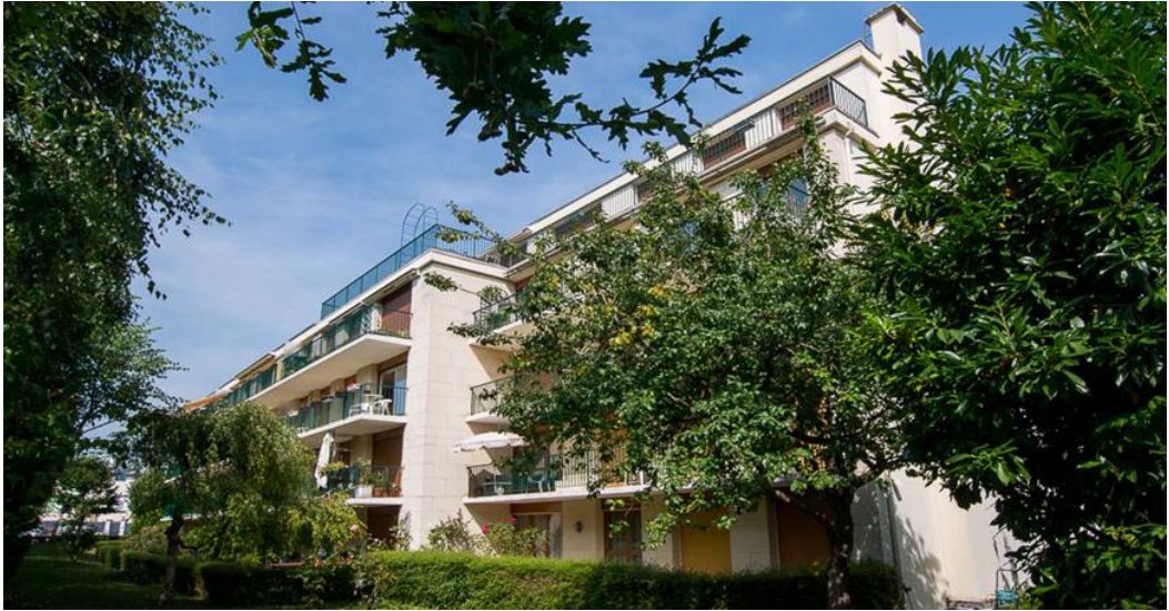
État 2017. Façade sur le jardin. Photos Arnaud Lesné.
