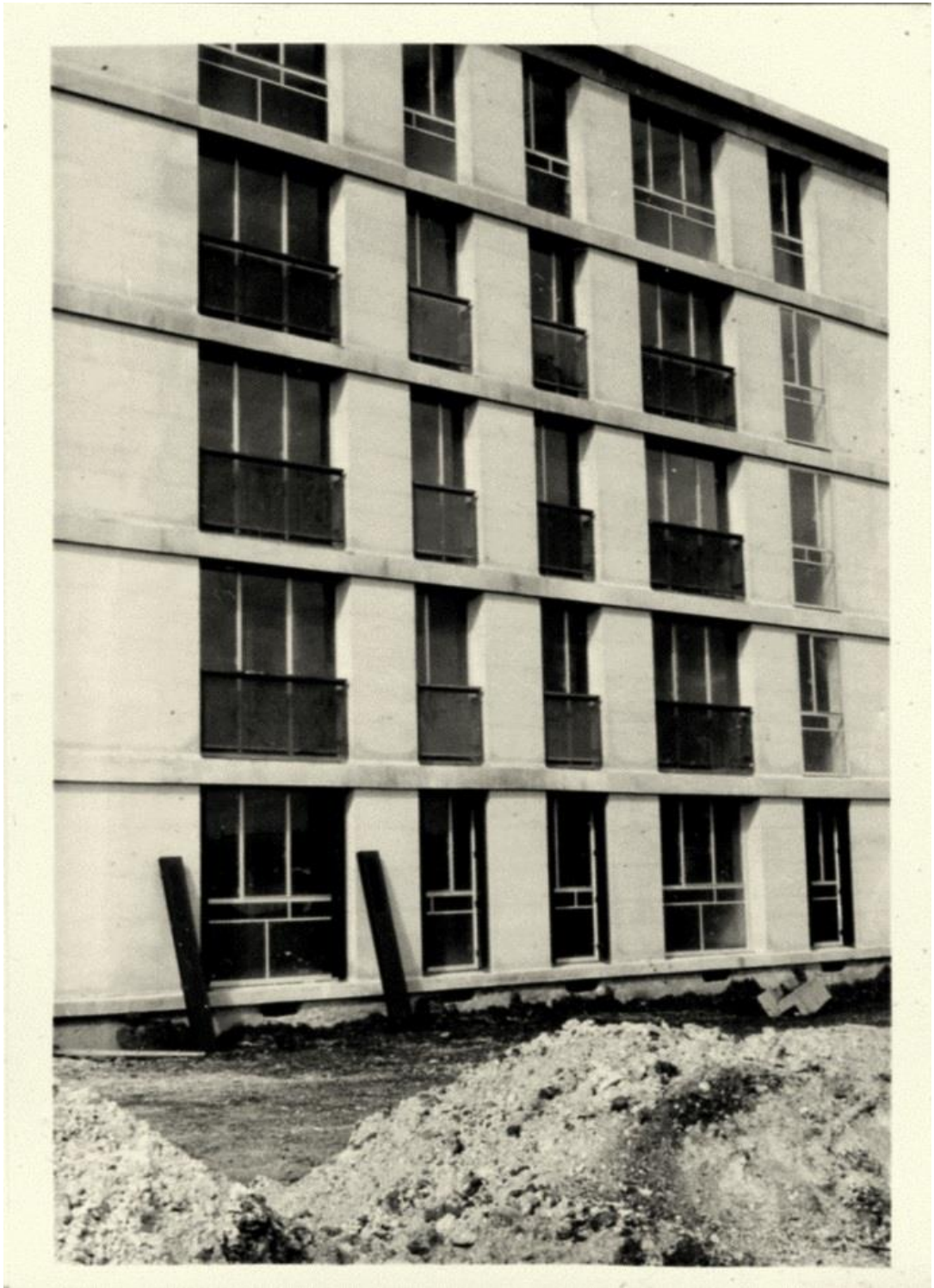
Façade sur la rue pendant les travaux. Photo de chantier. Fonds Lesné-Bernadac.
