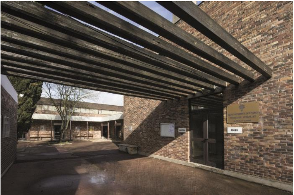
Le patio et l'entrée du foyer.
