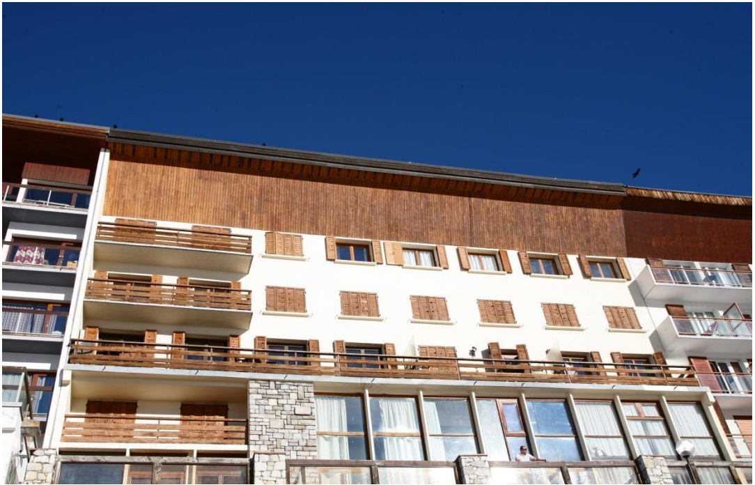
Façade sud. État 2019. Photo Vincent Lesné.
