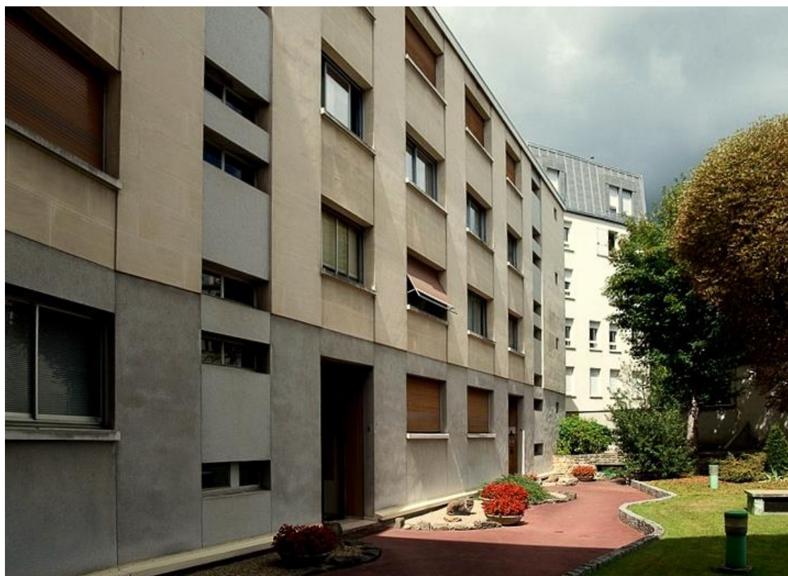
État 2018. Vue de la façade arrière. Photo Arnaud Lesné.
