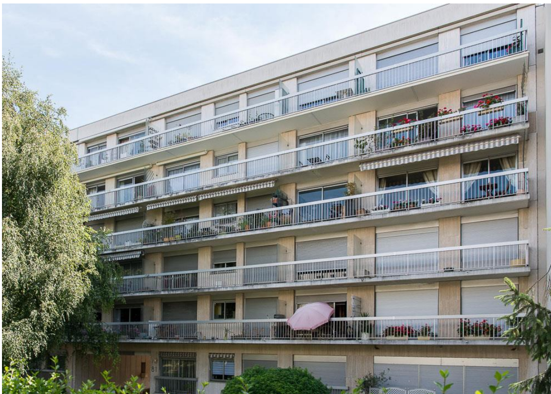
État 2017. Façade de l'immeuble sur rue. Photo Arnaud Lesné.
