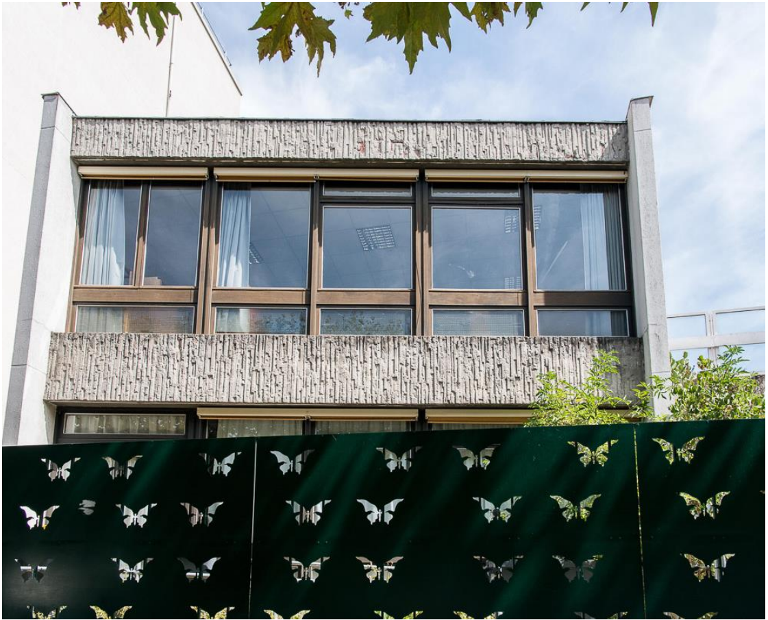
État 2017. Détail des allèges et bandeaux en béton. Photo Arnaud Lesné.
