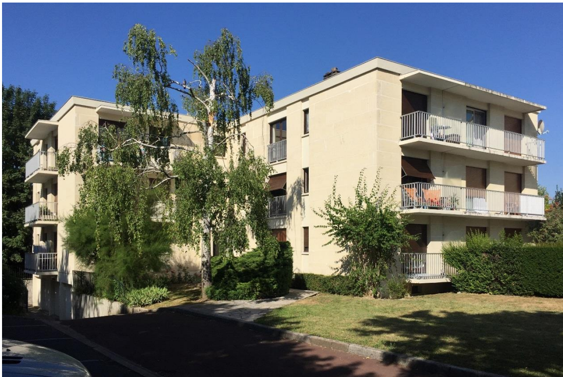
État 2019. Façade principale. Photo Anaelle Lesné.
