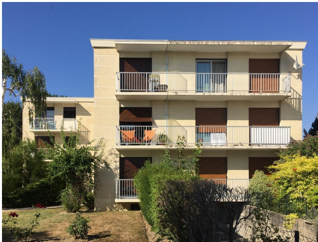
État 2019. Détail de la façade. Photo Anaëlle Lesné.
