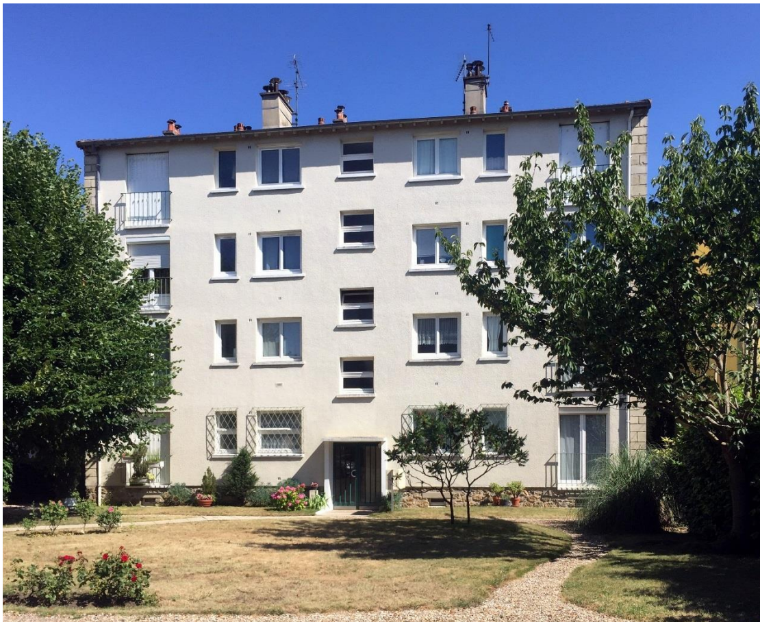
État 2019. Façade principale. Photo Anaëlle Lesné.
