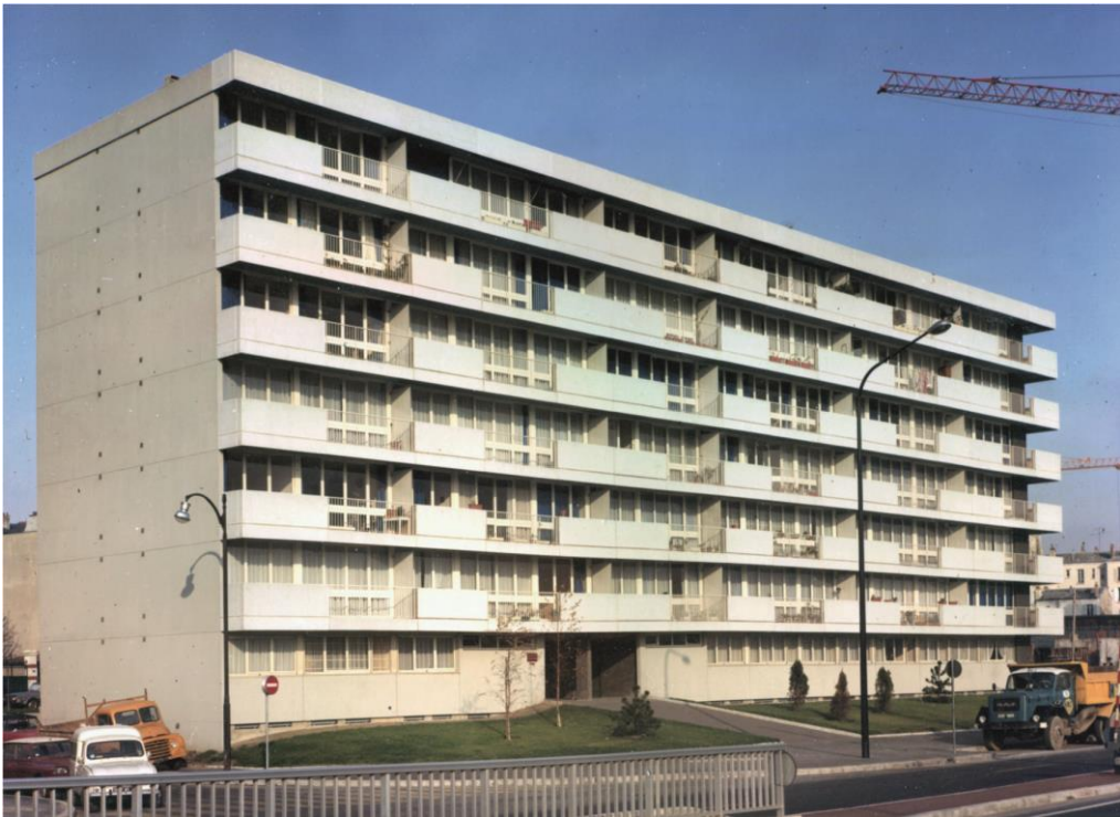
Façade sur le quai. Photo Olivier Lesné.
