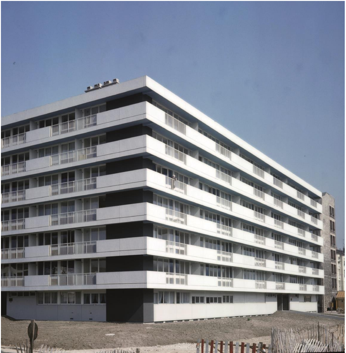
Fin de chantier. Photo Olivier Lesné.
