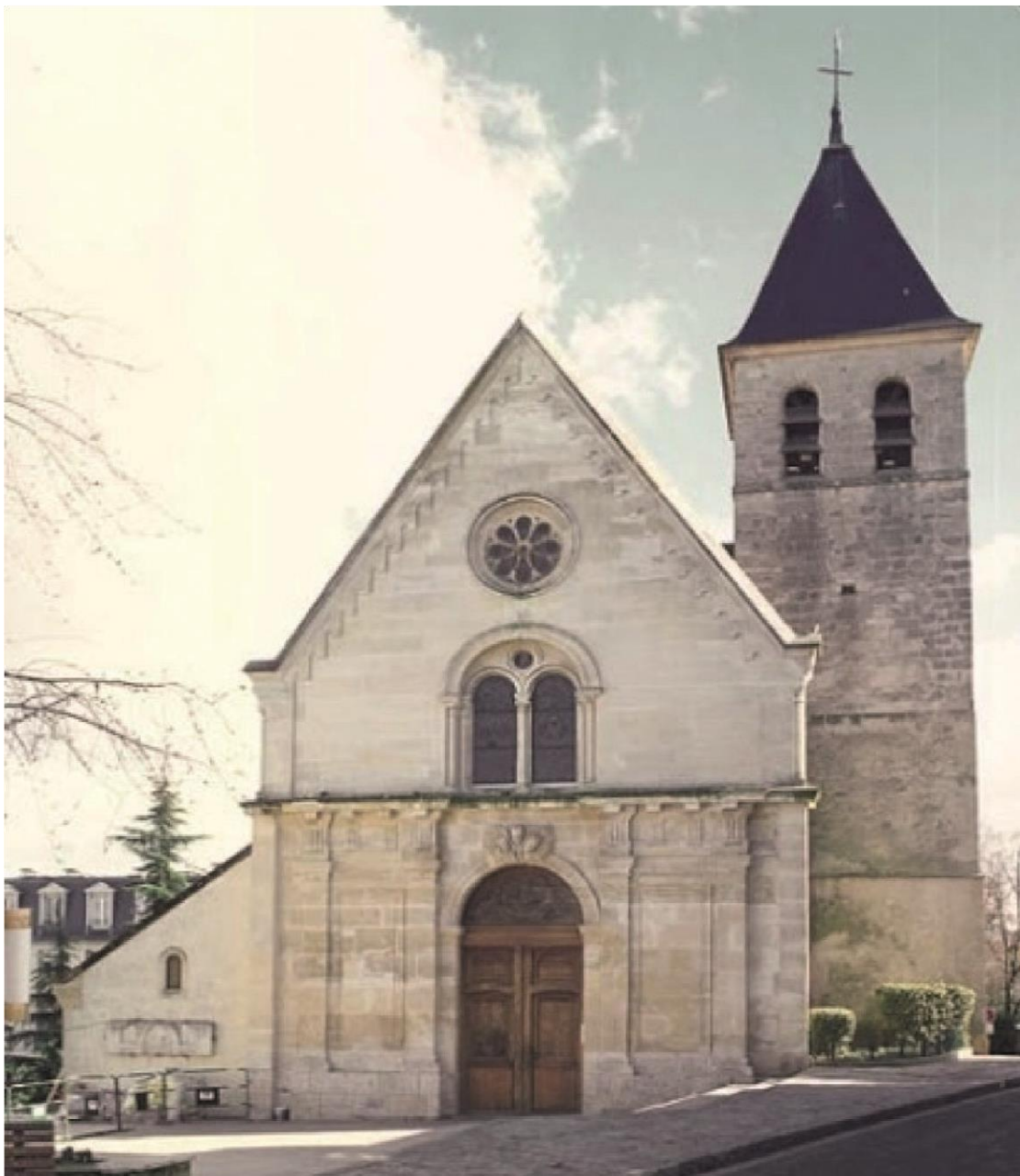
Fin de chantier, Photo Olivier Lesné.
