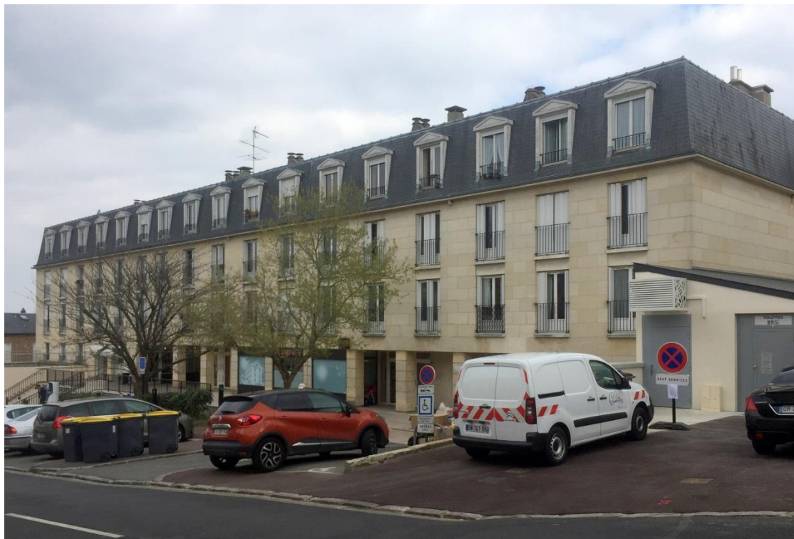
État 2019. Façade sur la rue Chaude. Photo Anaëlle Lesné.
