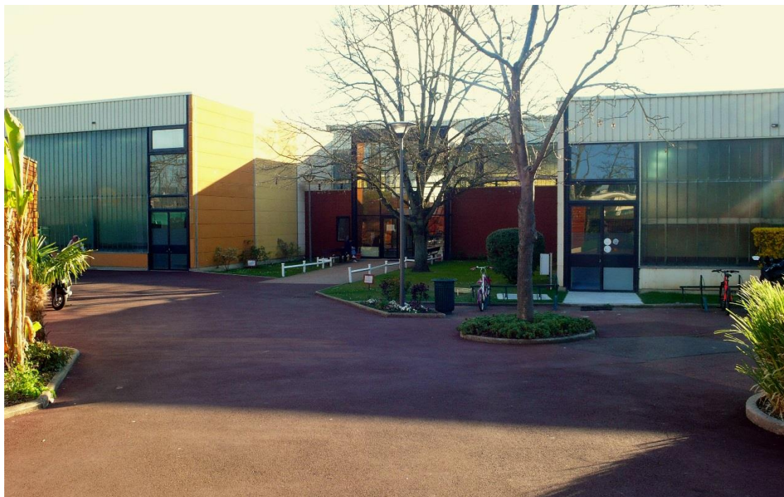
État 2019. Entrée principale du gymnase. Photo Eric Lesné.
