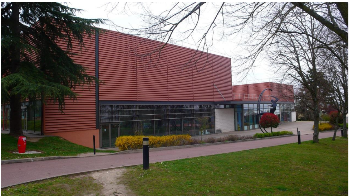
État 2019. Façade principale du gymnase. Photo Eric Lesné.
