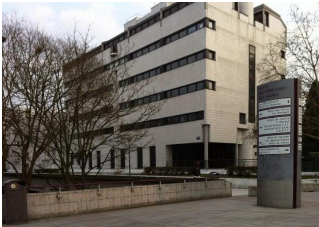
État 2016. Façade sur la place.
