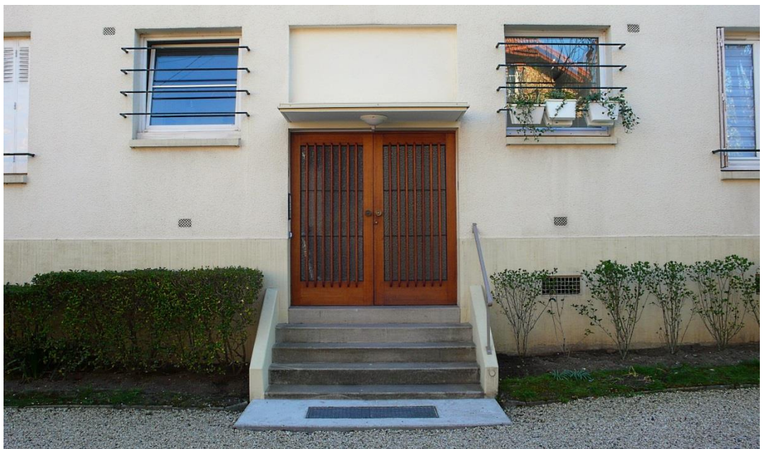
Détail de l'entrée. État 2019. Photo Eric Lesné.
