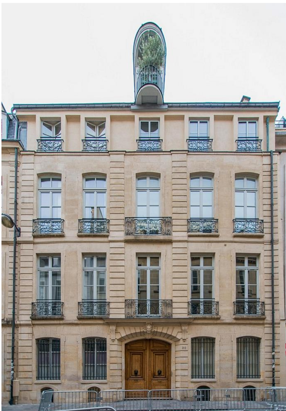
État 2017. Façade du N°32. Photo Arnaud Lesné.
