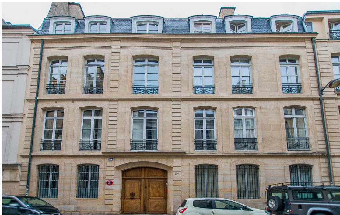
État 2017. Façade du n° 34. Photo Arnaud Lesné.
