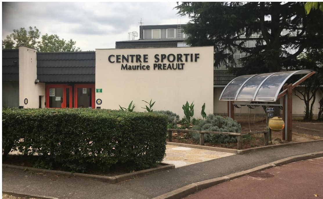
État 2018. Photo Vincent Lesné.
