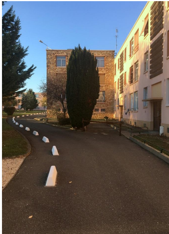
État 2018. Façades bât. C et pignon bât. D. Photos Vincent Lesné.
