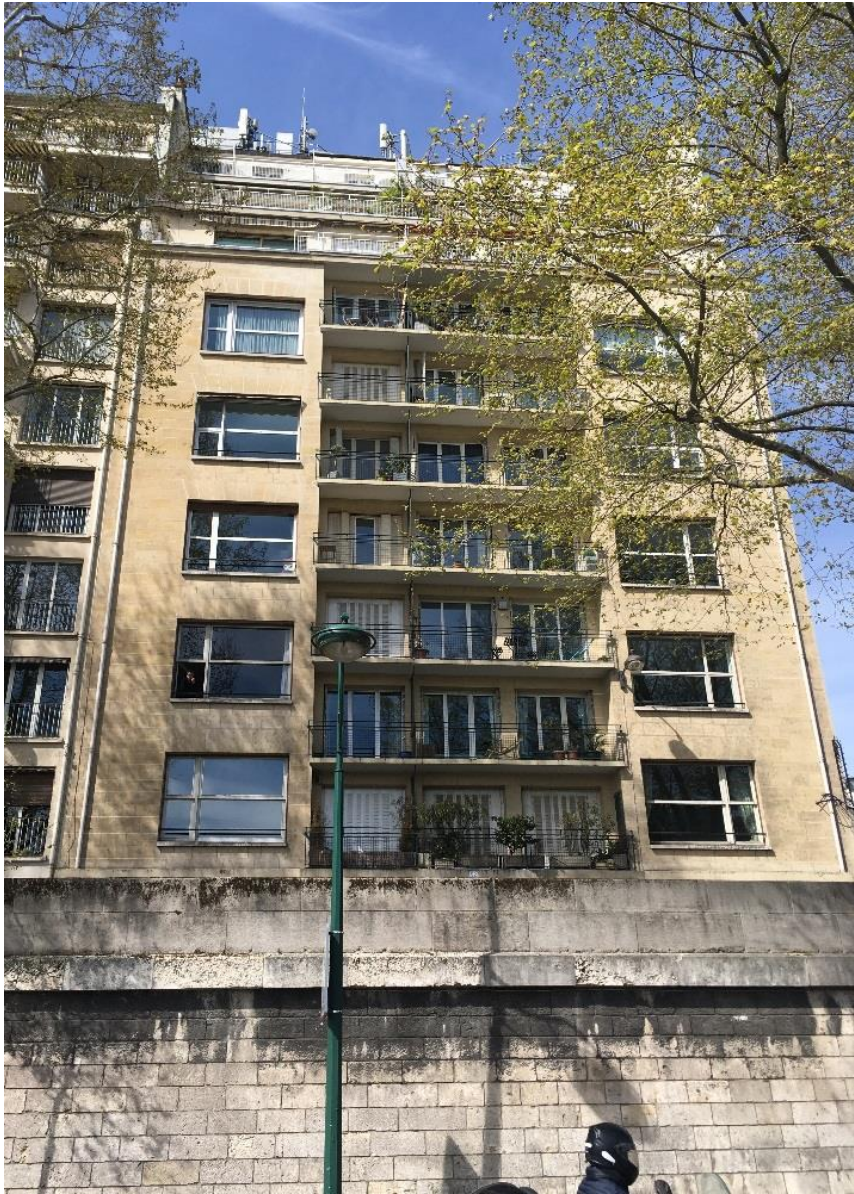
Façade vue depuis le quai. État 2019. Photo Vincent Lesné.
