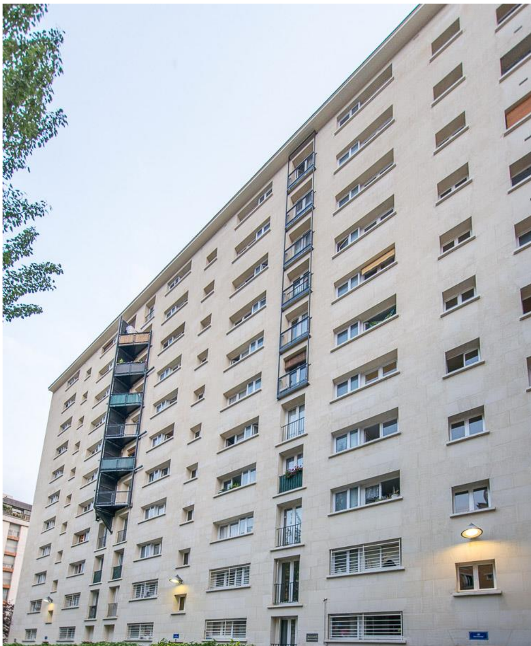
État 2017. Façade réhabilitée récemment. Photo Arnaud Lesné.
