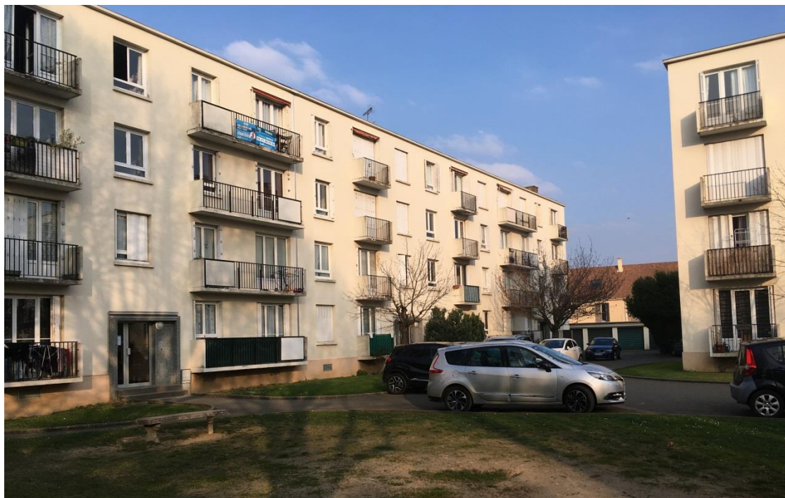
État 2019, façade sud. Photo Eric Lesné.
