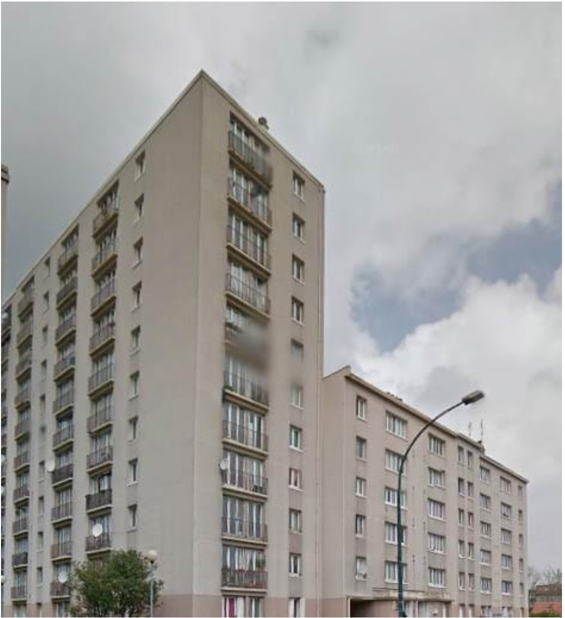
État 2016 de la construction initiale (avant récente réhabilitation).
