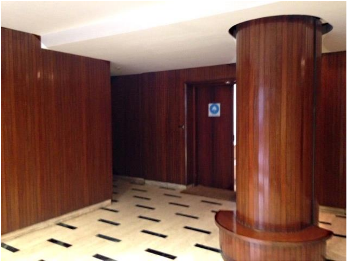
Entrée de l'immeuble. État 2017. Photo Vincent Lesné.
