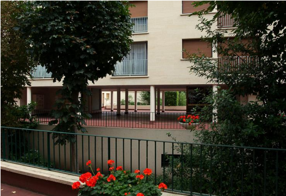
État 2017. Vue de la façade sur cour. Photo Arnaud Lesné.
